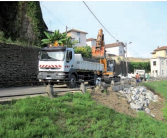
Des travaux importants ont dû être réalisés par la commune route de la Fontaine avec enrochement du bas-côté pour prévenir un affaissement de la route (coût : 12 400 euros).
