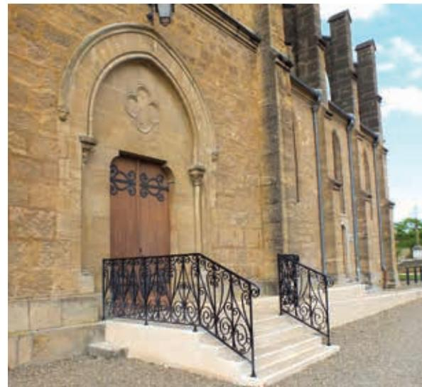
La rampe d'accès handicapés, réalisée par les Services techniques, a pu être intégrée à une entrée latérale du monument historique.
