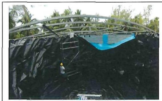
Exemple de construction de réservoir métallique
