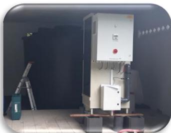
Mise en route des électrochlorateurs et désaffecter les stations de désinfection au chlore gazeux.
