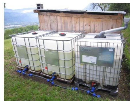
Il faut également mettre en place un **système de récupération des eaux pluviales**, qui seront utilisées en priorité pour l'arrosage manuel.
